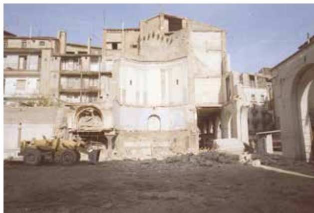
Demolición de la iglesia de San Francisco, con porches abiertos en capillas de la derecha (Foto ANM, 1984)
