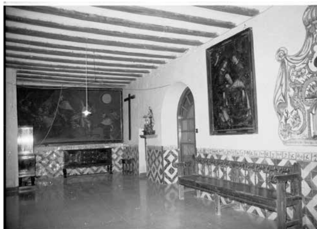
Vestíbulo de la clausura antes del derribo (Foto ANM, 1980)
