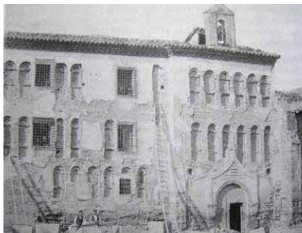
Edificio del Colegio de Santa Cruz-Seminario antes de su demolición
